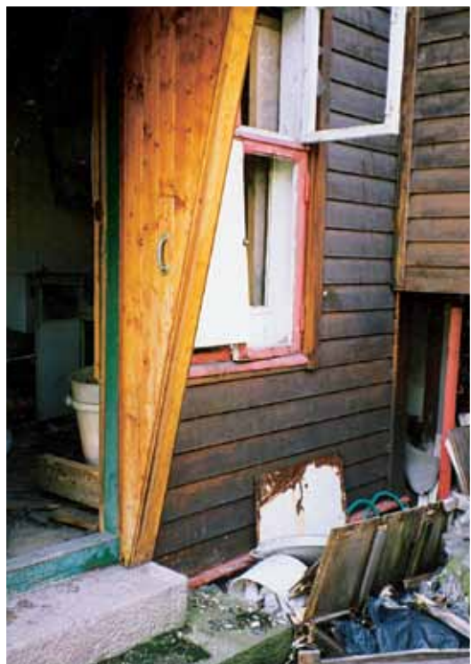
Vinterhage før restaurering.
