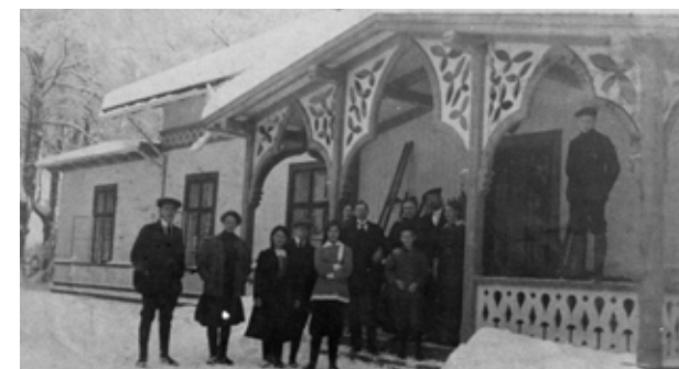
Hoffdamens vinterslott Bjerke Opaker i Grue.
