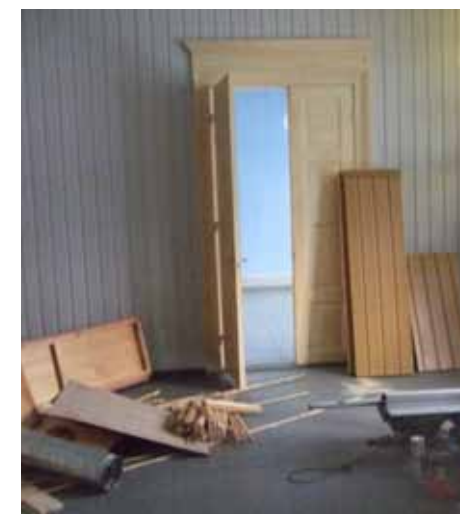
Våren 2010 var Nor igjen byggeplass...
