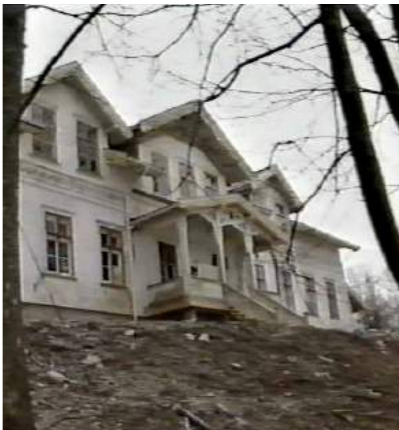
Hovedbygningen under restaurering i 1993.
