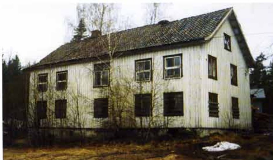
Hovedhuset på Holtane Bruk før flytting.
