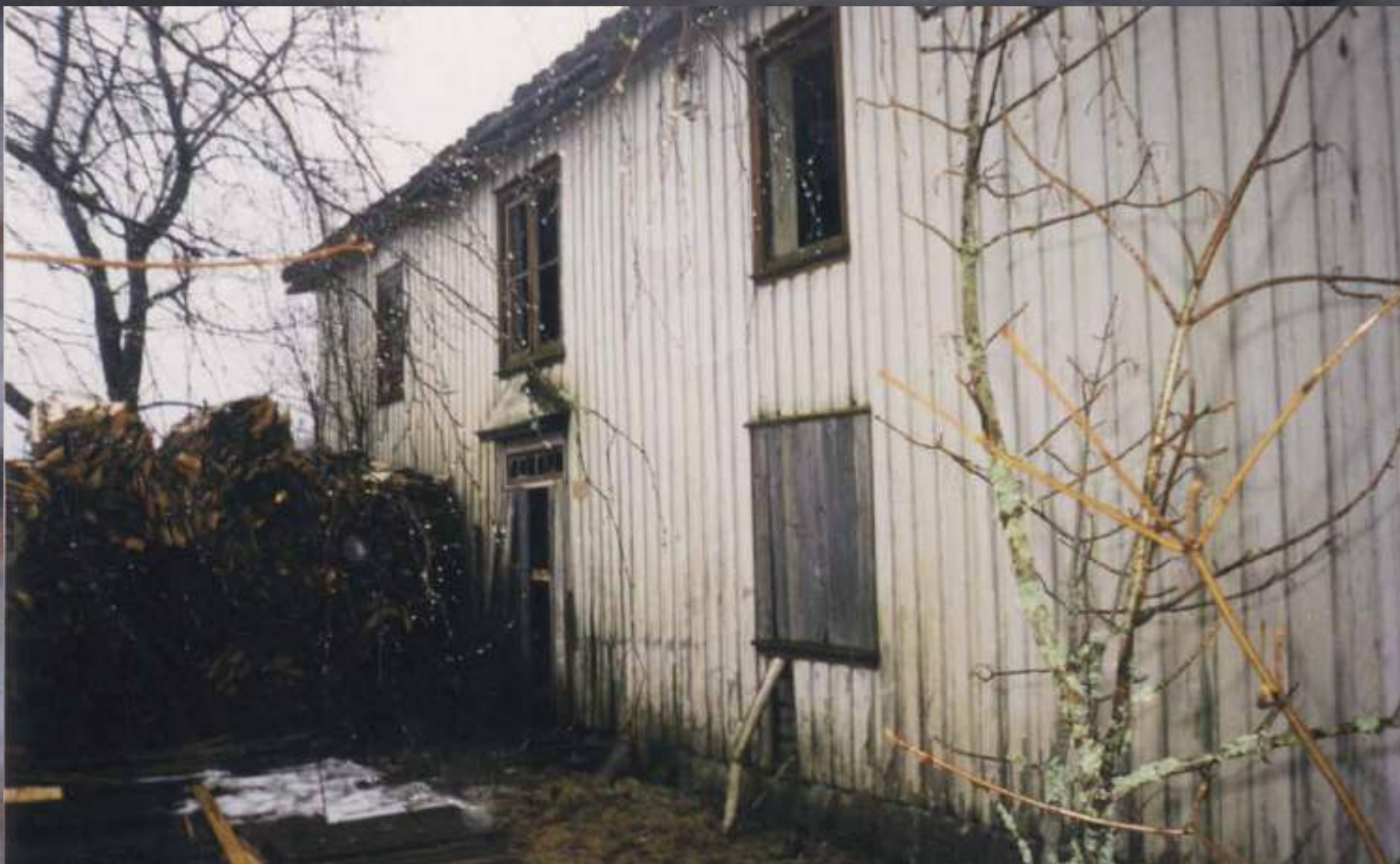
Hovedbygningen ved Holtane bruk 1998 - fasaden ble brukt som buffer for store stabler med tømmerstokker.
